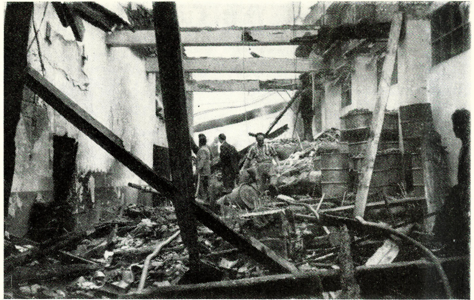
Un aspecto del almacén donde se declaró el incendio. (Foto Payá)
